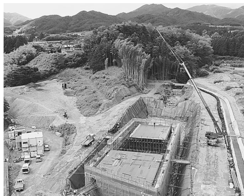
図表 I-1-(6)-8 土曾川ボックスカルバート設置
