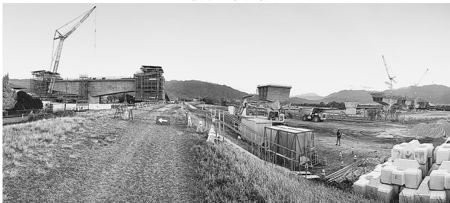
図表 I-3-(3)-3 リニア釜無川橋梁工事現場(中央市)
