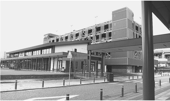
周辺整備が進む北陸新幹線敦賀駅
